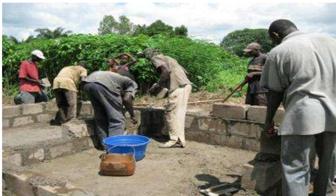
Construction de latrines ECOSAN à Goubi, Photo ANCE-Togo, Mars 2015
