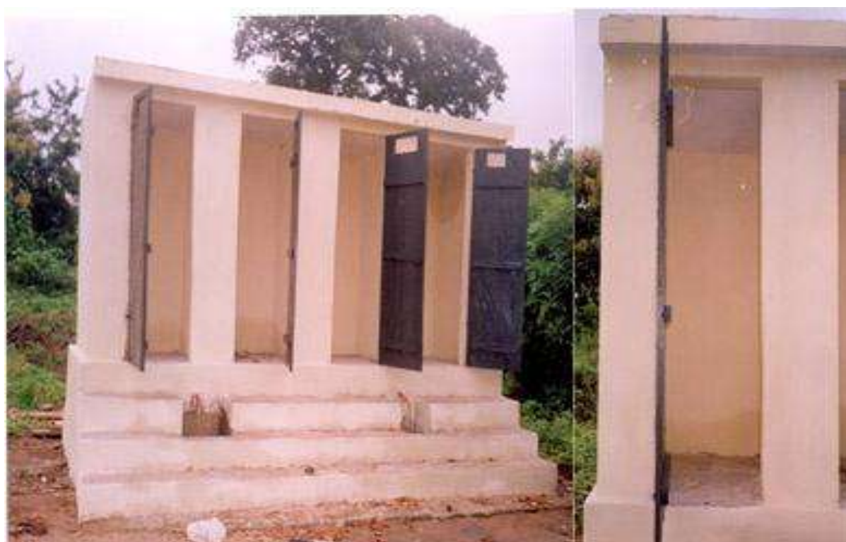
Latrine ECOSAN prête pour utilisation, Photo ANCE-Togo, 2015
